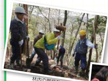
林内の階段整備
