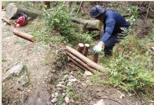
伐採木を利用した山道の補修作業
