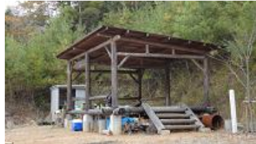
作業小屋兼休憩小屋
