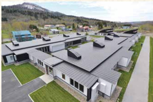
一の橋集住化住宅
