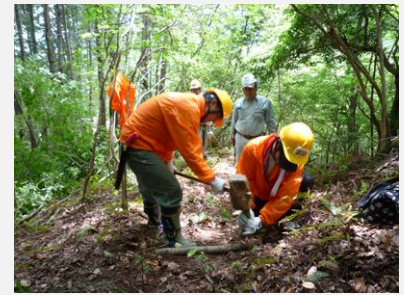
小畑地区での間伐材を利用しての階段づくりの様子
