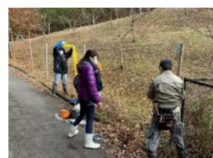
(獣害防護ネット設置)
